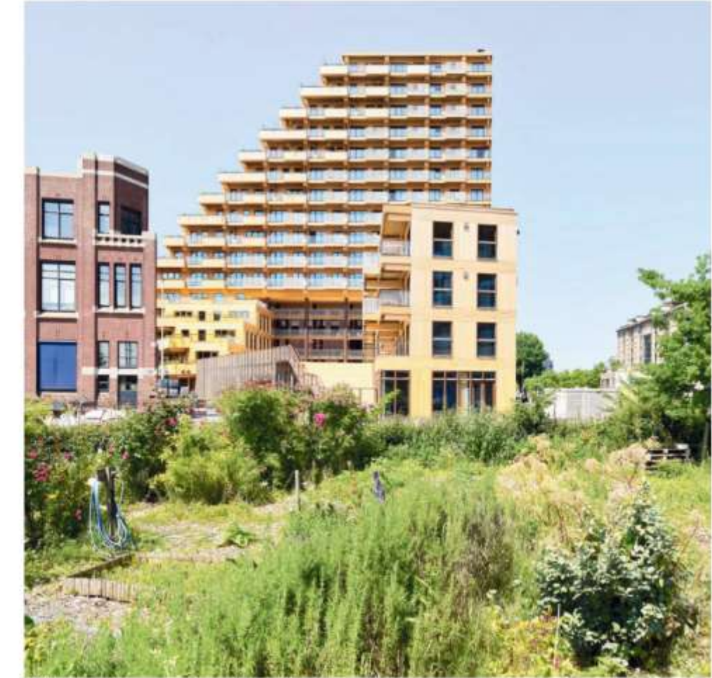
SAWA in Rotterdam. Het eerste woongebouw van hout, ruim 50 meter hoog. FOTO: WALTER HERFT
