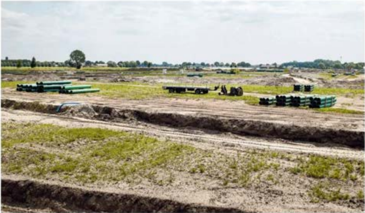
Aan de oostkant van het Brabantse dorp Rijen moet over een paar jaar de nieuwbouwwijk Tussen de Leijen ontstaan. FOTOGRAFIE: HEBERDALESEN
