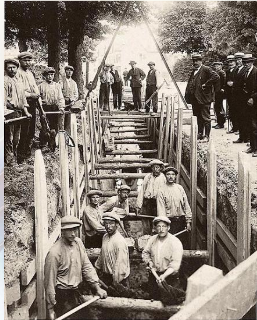
Aanleg van een riool in Breda
